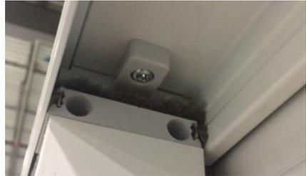
Fermer le volet ouvrant pour installer le bloc d'étanchéité de tête au centre du cadre, à la rencontre des volets.
