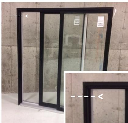
Lever la porte en position verticale dans l'ouverture. À l'aide de cales, centrer le haut du cadre dans l'ouverture. Du côté du volet ouvrant, placer une vis d'installation dans le coin supérieur afin de maintenir le cadre en place.
